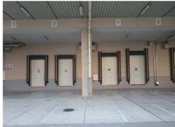
ドックシェルター完備のターミナル保冷荷捌室
