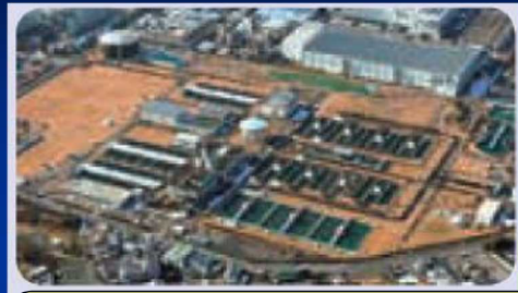
春日井浄水場
