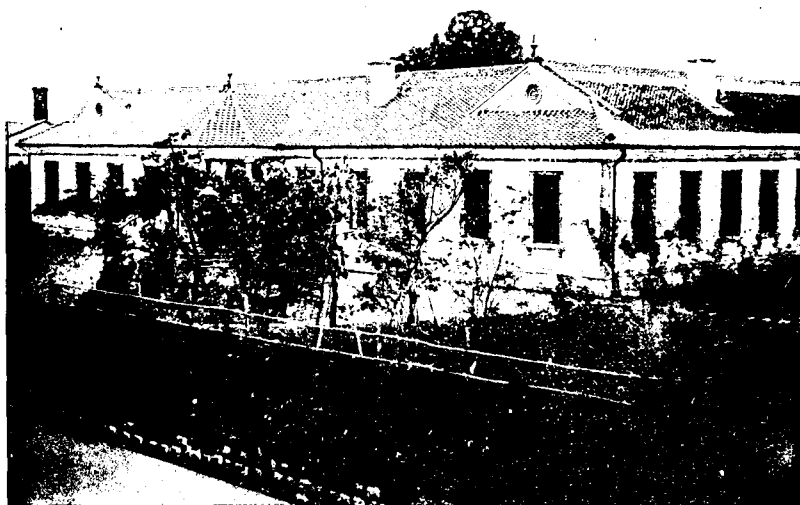
東京衛生試験所舊廳舎
