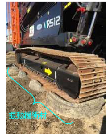
振動緩衝材(大型タイヤ)
